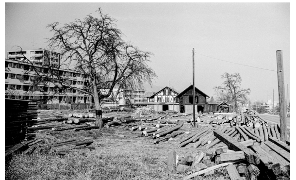
Holzlager Sägerei Suter, Heubach, mit Neubauten Drusbergstrasse, 1922
