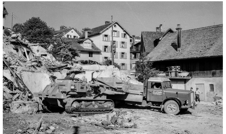
Abbruch der Oberen Mühle, 1961
