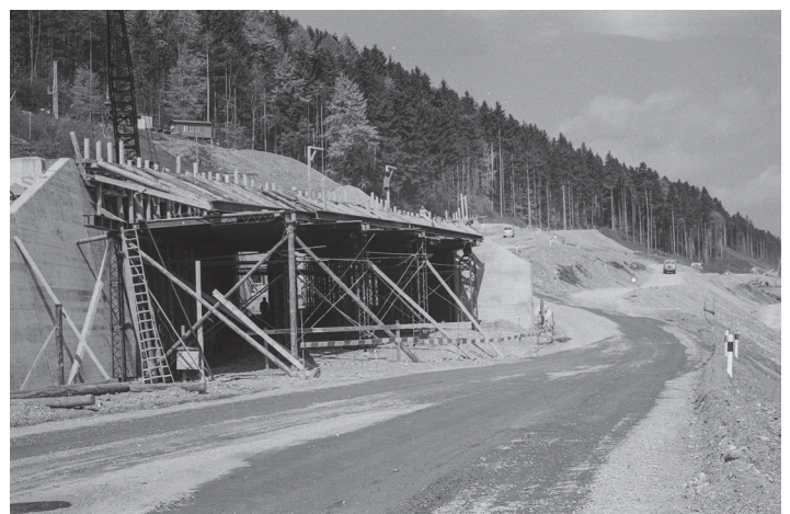
Die Unterführung der Bergstrasse ist betoniert, 1965
