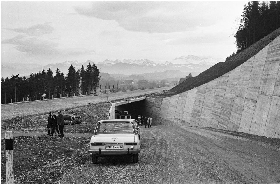
Bau von Unterführung und Bergstrasse – die teuerste Nebenstrasse der N3, Kosten Fr. 4'700'000.–, 1966
