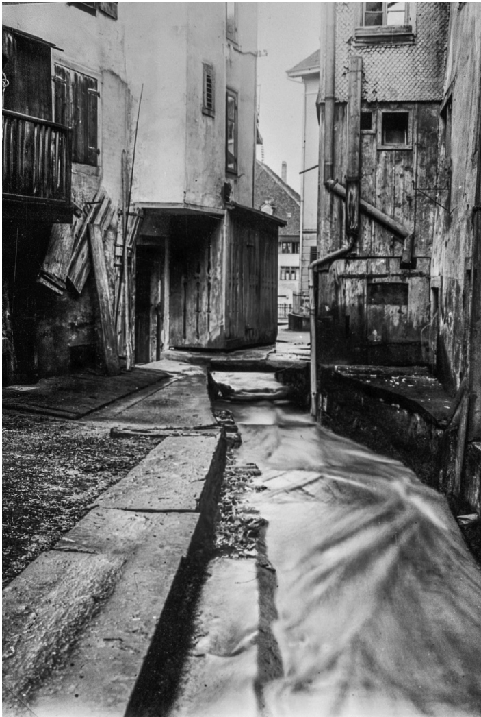
Der offene Dorfbach, Blick Richtung Sust, 1920
