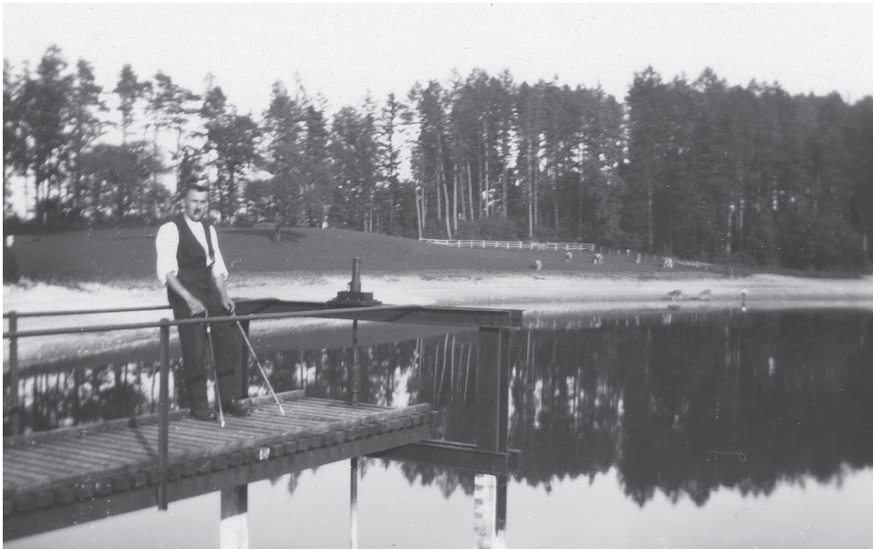
Weiherwart Fritz Bärtschi auf dem Steg des Grundablasses
